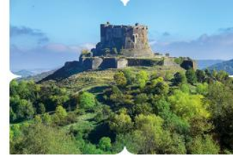
8. Château de Murol - 2017 185 000 visiteurs / an
